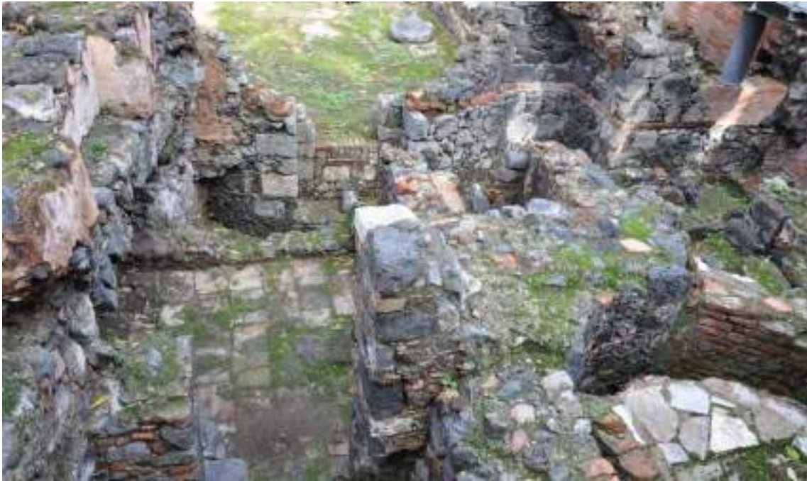
Fig. 8. Catania. Chiesa della Rotonda. Strutture murarie pertinenti alle terme di età imperiale (IBAM-CNR, C. Pantellaro).
