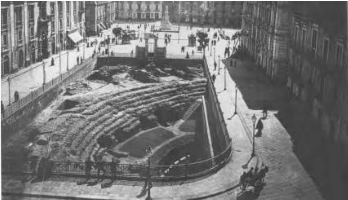
Fig. 24. Catania. Piazza Stesicoro. Foto che mostra le strutture dell'anfiteatro immediatamente dopo gli scavi di F. Fichera nel 1904-1905 (da NICOLOSI 1985).
