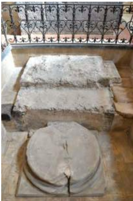
Fig. 41. Catania. Cattedrale. Base di colonna e pilastro della struttura medievale della chiesa distrutta dal terremoto del 1693 (IBAM-CNR, G. Cacciaguerra).
